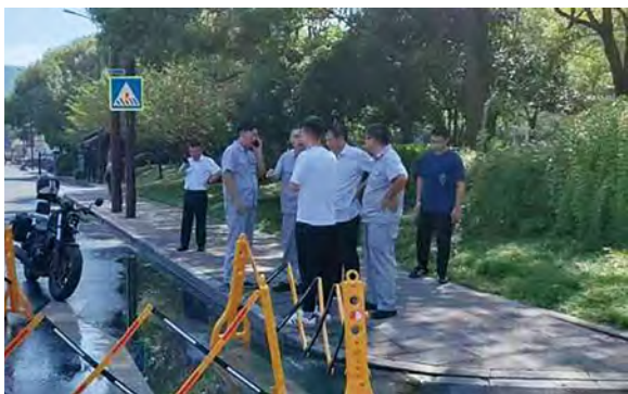
图1 协会组织管线单位向施工方实地交底现场
