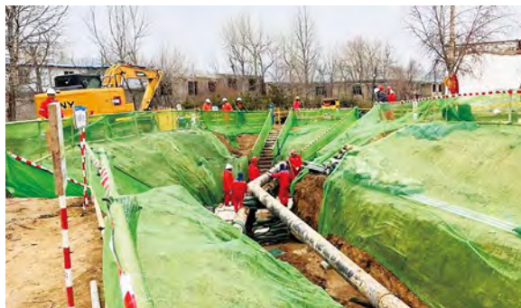
图2 动火作业现场
