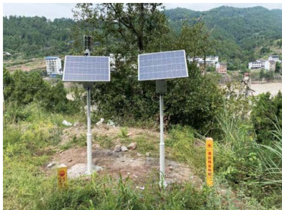
图3 管道滑坡地质灾害监测
