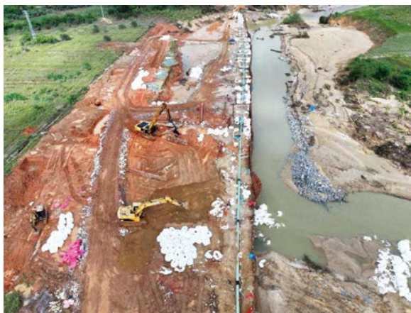
图2 现场处置后的管道
