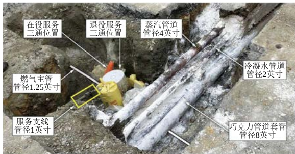
图1 事故现场开挖
