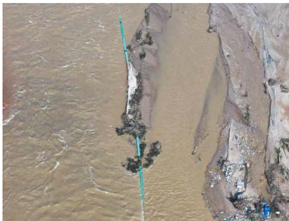
图1 茂名—阳江段管道露管现场
