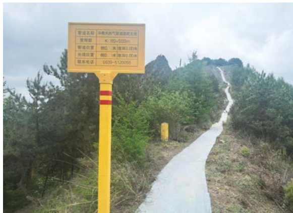
图3 水泥毯铺设巡检通道示例
