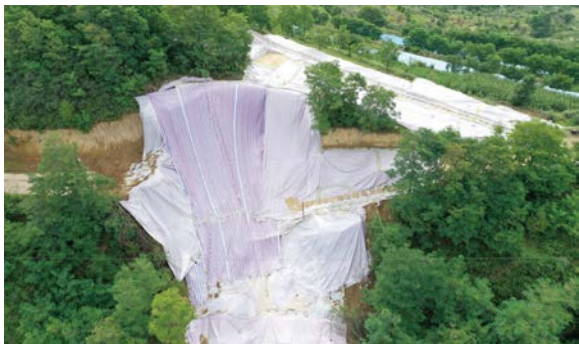
图1 坡面覆盖防护示例
