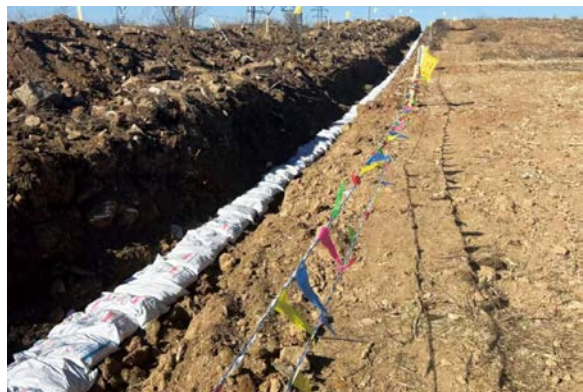
图2 完成开挖治理的管道
