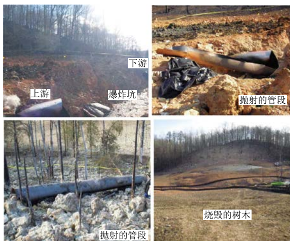
图2 Line200管道事故现场情况
