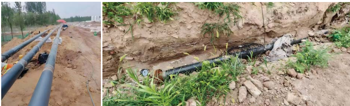
图1 潍坊高新区次高压氢气管道施工现场
